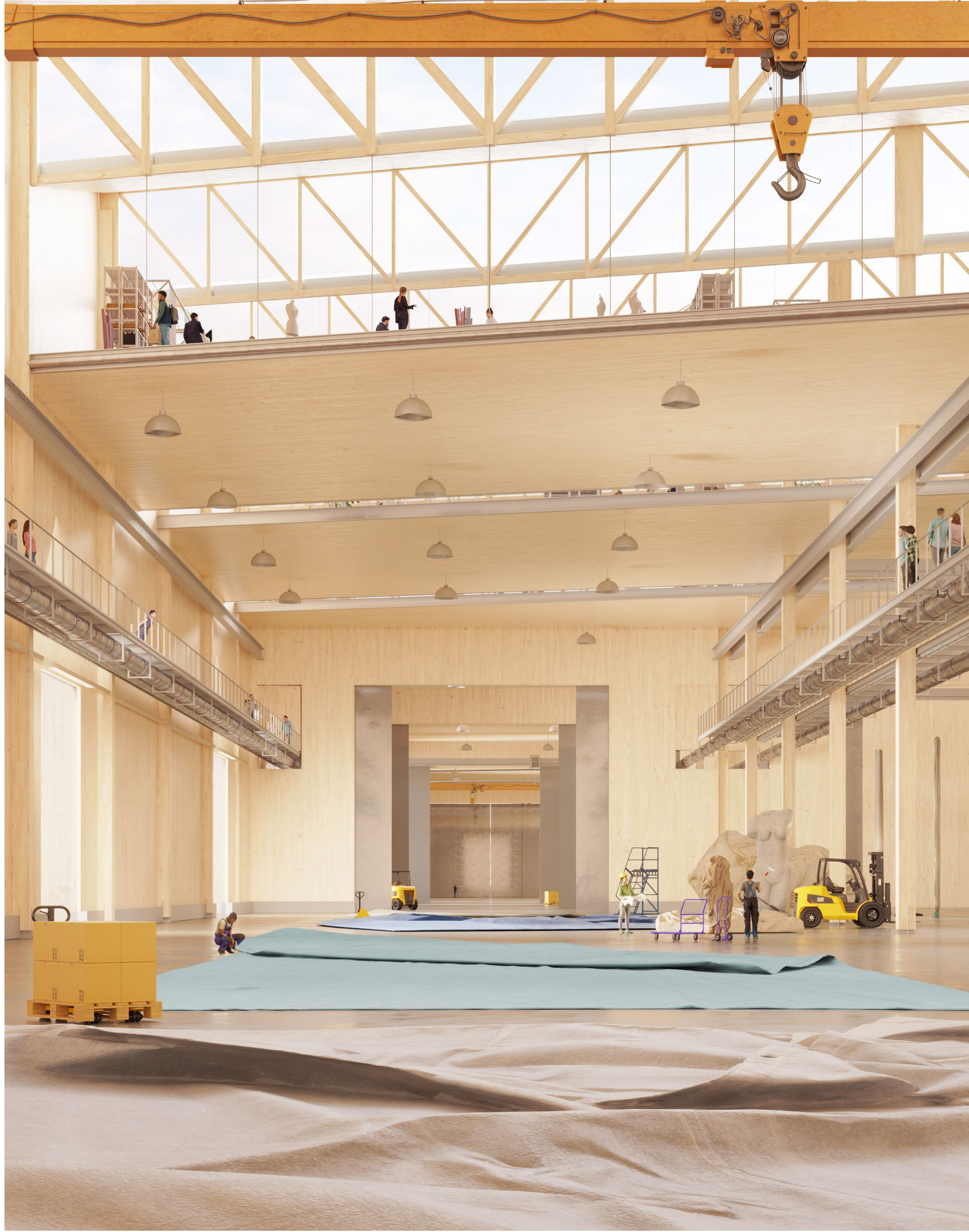
Un unico capannone, costruito interamente in legno, ospita i Laboratori, è servito da carriponte, e beneficia di accesso diretto dalla strada lungo il lato Ovest.
