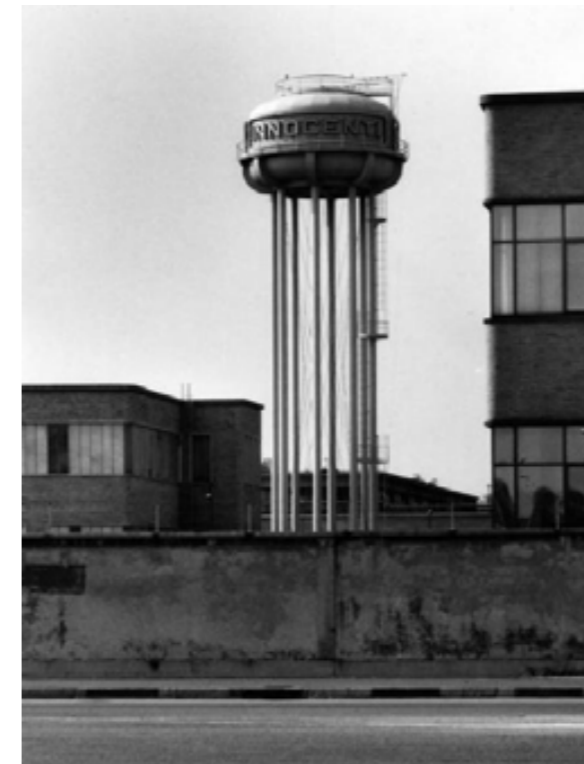
Milano. Via Raffaele Rubattino - edifici industriali - muro perimetrale - INNSE - Innocenti, Gabriele Basilico.
