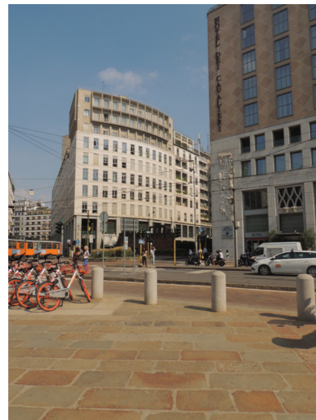
foto: piazza Missori, Milano, settembre 2020 pavimentazione in masselli di recupero
