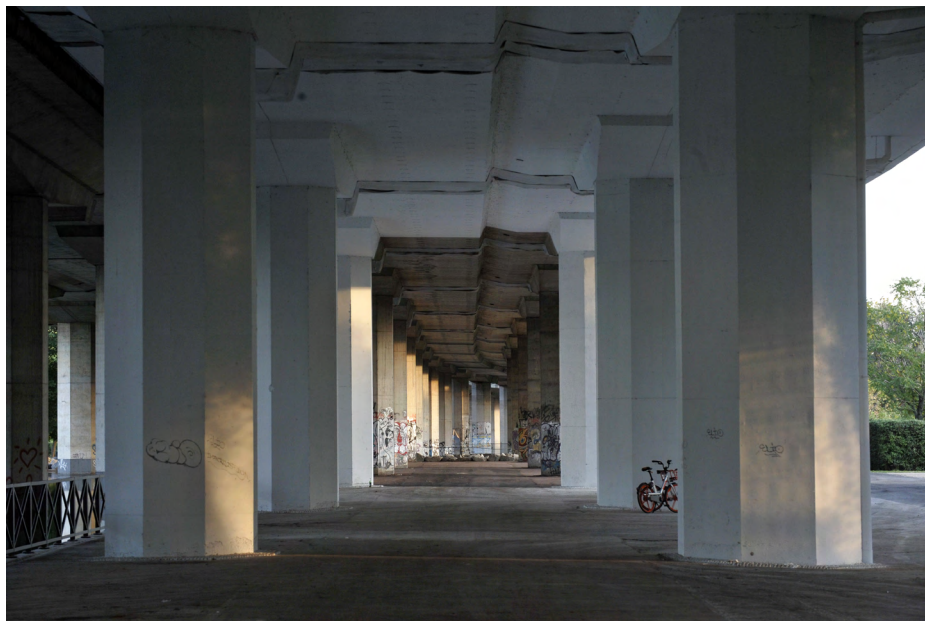
fig. 22 Spazi sotto al viadotto della tangenziale est. Fonte: Comune di Milano
