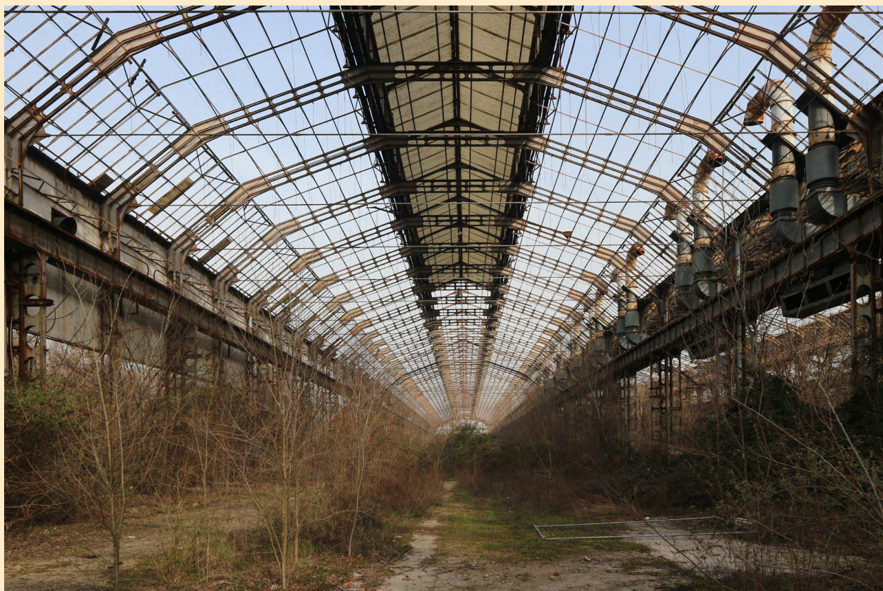
fig. 10 Lo stato attuale del c.d. "Palazzo di Cristallo".
